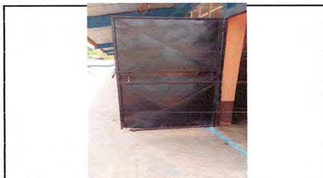
Foto 3: Sustitucion de Puertas de la direccion de primaria.
