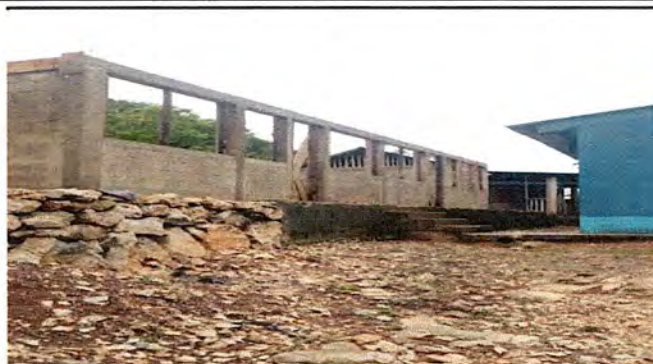
Foto 2: Instalacion de ventanas del aula de preprimaria, y el repello interior y exterior de las ventanas despues pintarlo.
