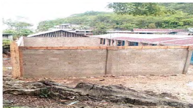
Foto 4: Instalacion de techos y soldadura del aula de preprimaria,
