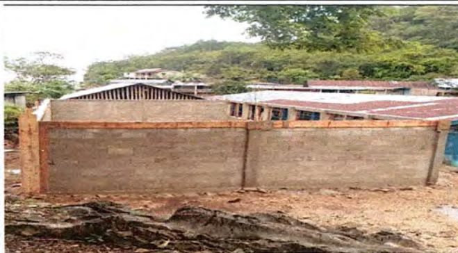
Foto 1: Colocación de mojinete del aula de preprimaria, y luego la reparación de pisos ceramicas dentro del salon de clase.
